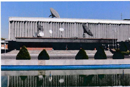
Südwestlicher Bereich der Fassade des Neuen Sendezentrums Юго-западная часть фасада Нового телецентра Datum/Дата: 10/2019
