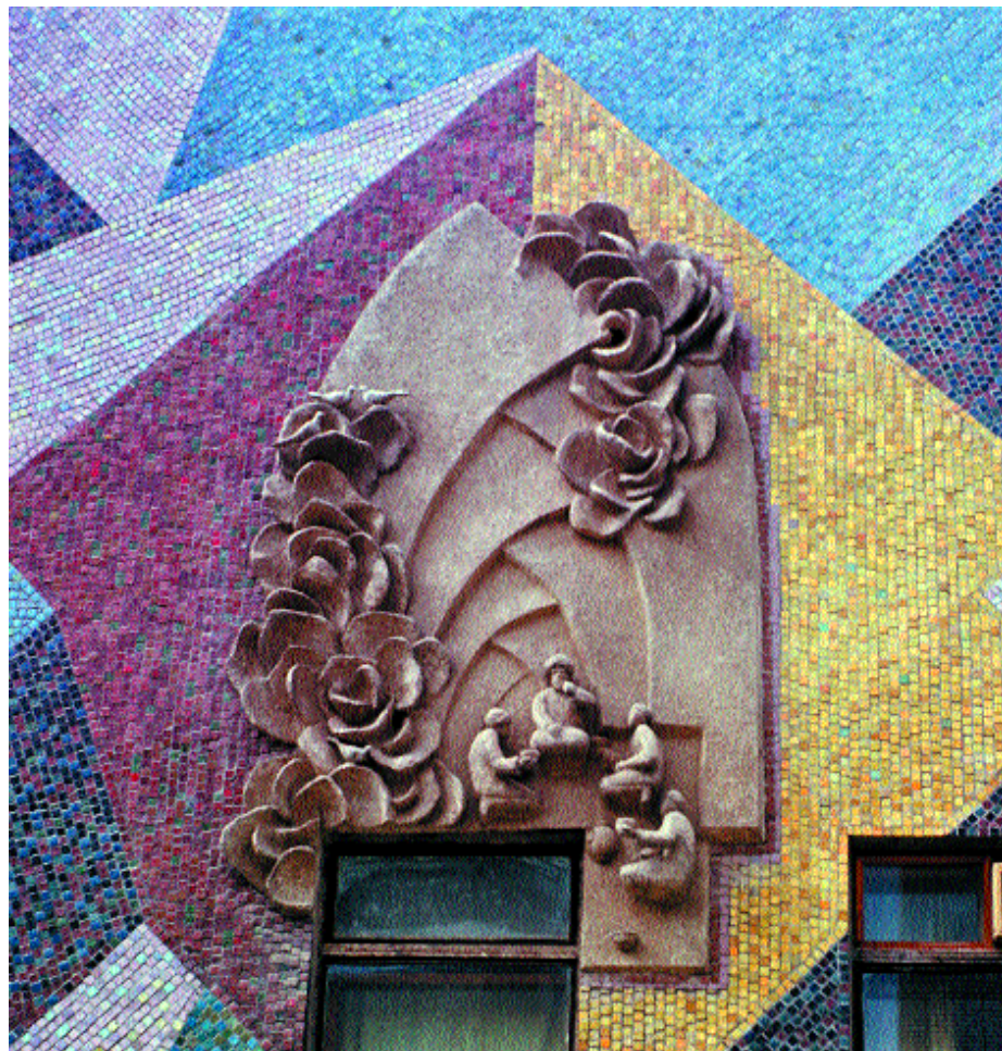
Ташкентский телецентр Фрагмент
